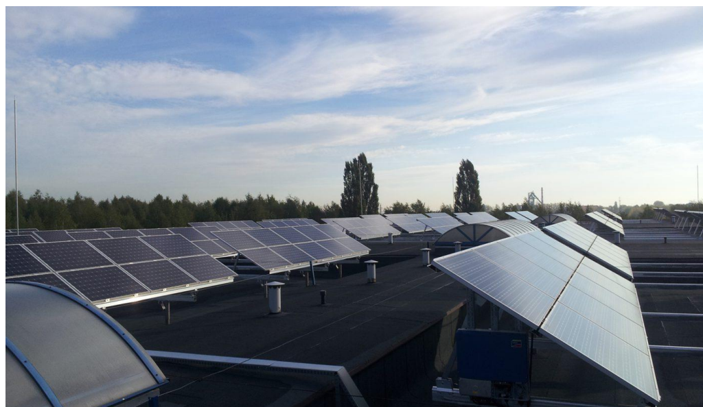
Rys. 7.13 Panele PV na zbiorniku wodnym w Czarnym Lesie
