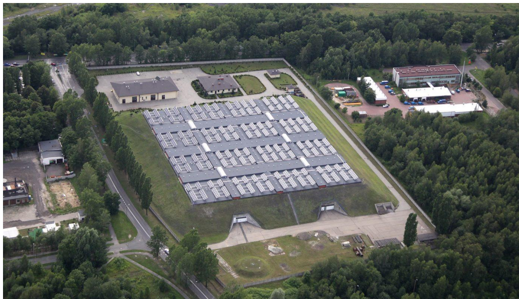
Rys. 7.12 Instalacja fotowoltaiczna 311 kWp - GPW Ruda Śląska
