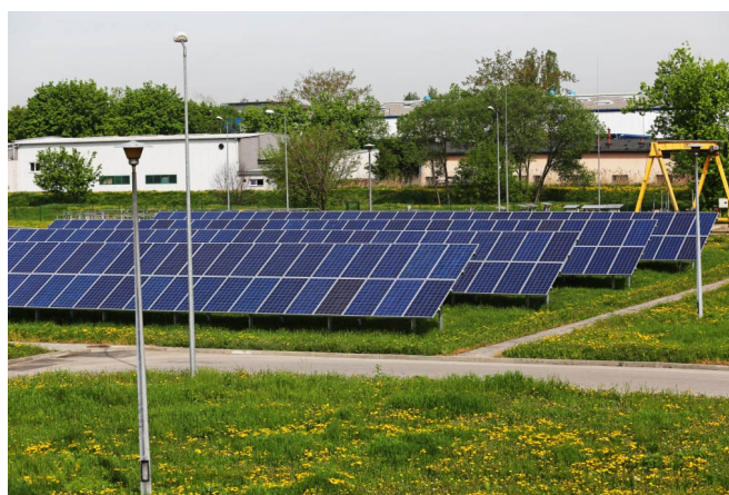
Rysunek 3.52: Elektrownia fotowoltaiczna PV1 [74]
