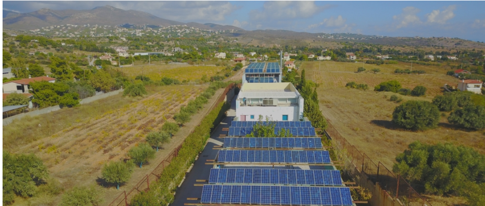
Rysunek 3.72: Elektrownia fotowoltaiczna PV2 [83]
