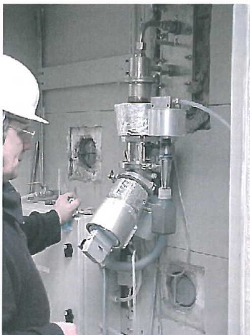
Rys. 1. Analizator AWP 2/3 firmy ZAP "KWANT" zainstalowany w Elektrociepłowni Będzin S.A.
